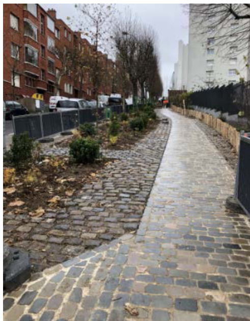
Photo 4: Exemple de trottoir en pavés en pierre (photo extraite du guide du Cerema « Adapter la voirie urbaine au changement climatique »)
