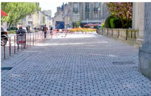
Photo 3: Exemple de pavés en béton poreux (Source: Eiffage)
