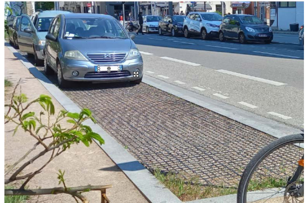
Photo 6: Exemple de revêtement alvéolaire avec des dalles PVC alvéolées et remplissage gravier (photo extraite du Cerema « Adapter la voirie urbaine au changement climatique »)
